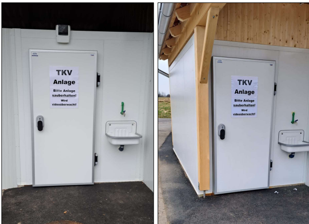
Bild links: TKV-Anlage in Ratschendorf (zwischen Rüsthaus und Teichhalle)
